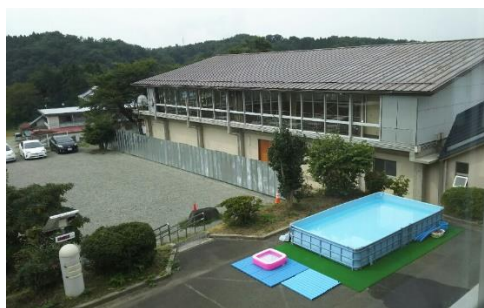
仮囲いができました！ 本格的な工事はこれから・・・
