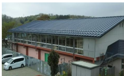
体育館外壁の塗装も終わりました。
